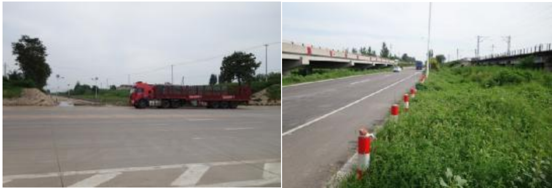
图 4-39 元氏段 427 乡道和 G107 国道引道，存在缺口（洪水发生时临时封堵） 现状漫水路大多为村民自行修建的土路，型式见下图：
