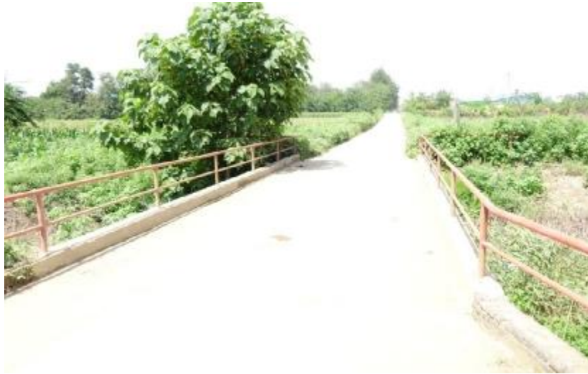
图 4-38 栾城段北安乐村桥 1 现状图，此处河道宽度约 200m，滩地 180m，主槽 20m，主槽位置桥宽 12.5m，滩地为漫水路，筑堤处存在缺口（洪水发生时临时封堵）
