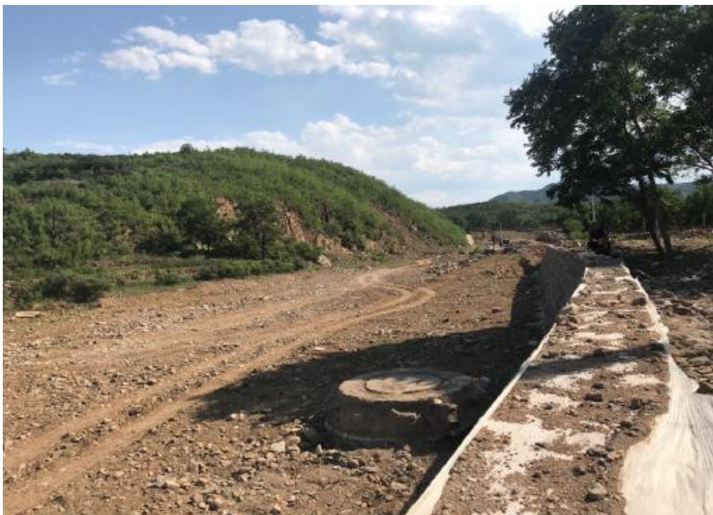
图 4-2 八一水库上游河道，左岸为已实施的中小河流治理护岸，右岸为山体
