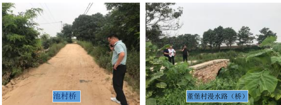
图 4-29 元氏段池村桥和董堡村漫水路（桥）2 现状图，阻水严重（拆除重建）
