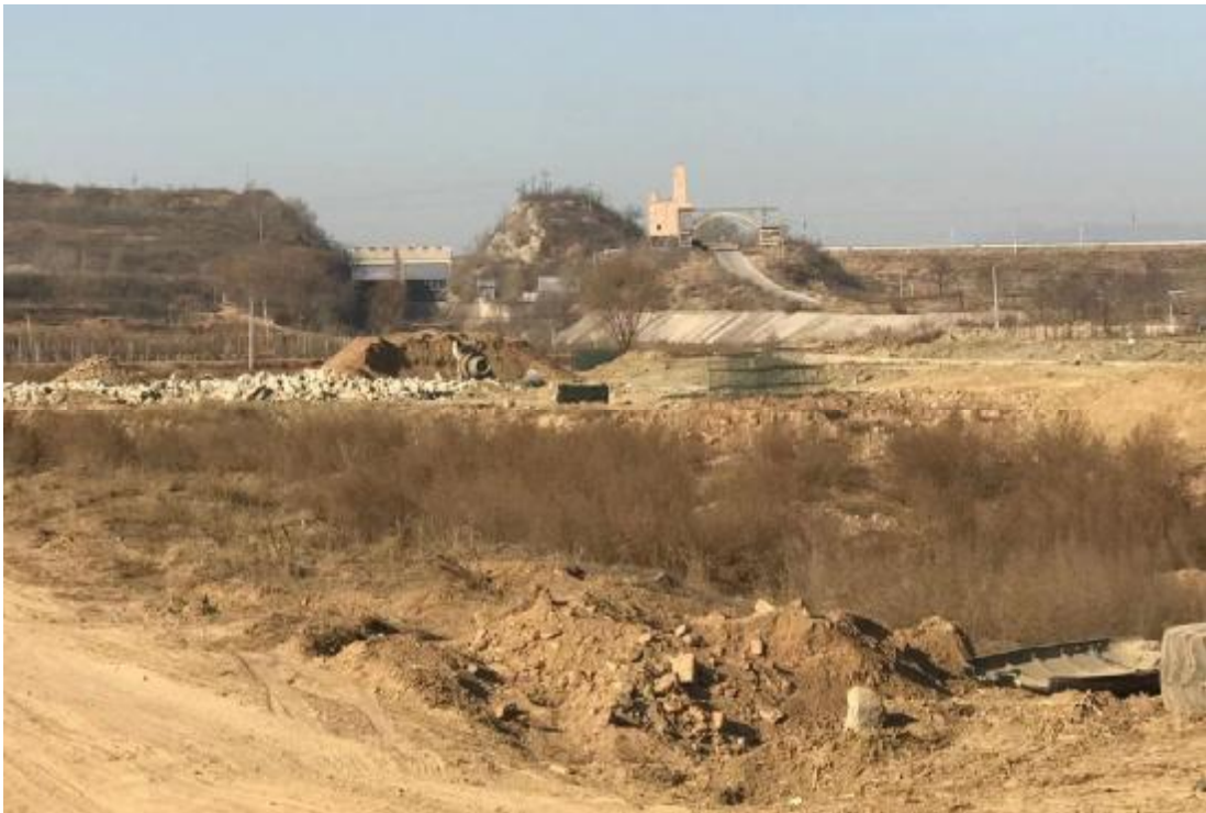
图 4-4 八一水库下游河道，溢洪道出口
