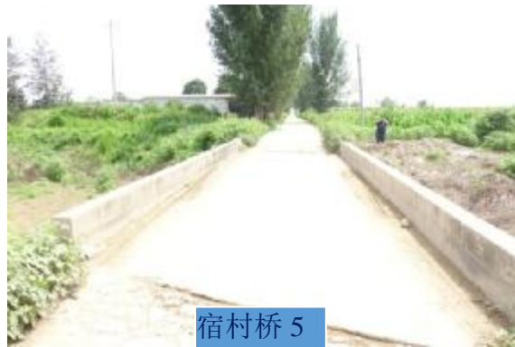
图 4-36 栾城段宿村桥 5 现状图，河道束窄，阻水严重（宿村桥 5 增加桥孔）
